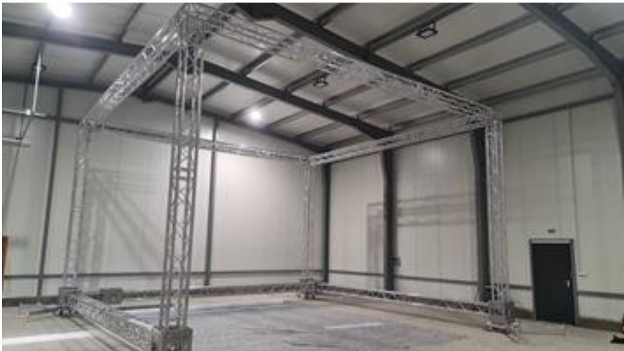
ezen a képen a vázszerkezet szállítás előtti összeállítása látható
